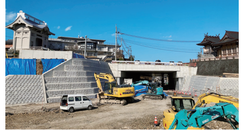
本妙寺トンネルも完成間近!
