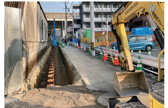
ポンプ場への導水路工事
